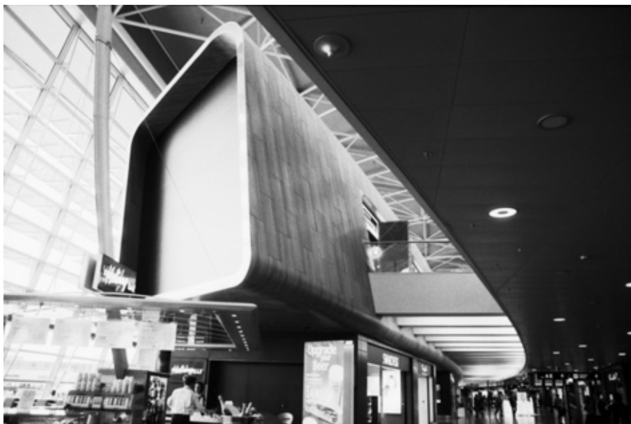
Terminal d'Aéroport / Zurich / Arch. Grimshaw
