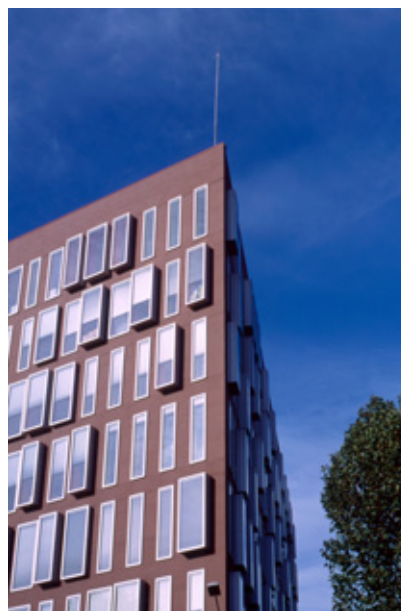
Bureaux / Aubervilliers / Arch. Brenac et Gonzalez
